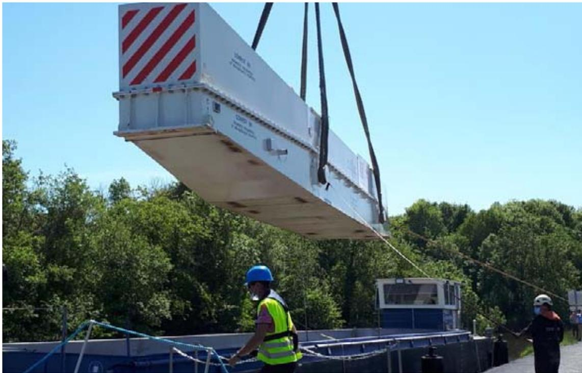
Le rotor, enfermé dans son sarcophage, a pu être hissé sur la barge grâce à une plateforme de grutage.
